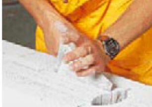
■ Recubra con mortero de manera que se llene completamente la garganta, sin exceso.
