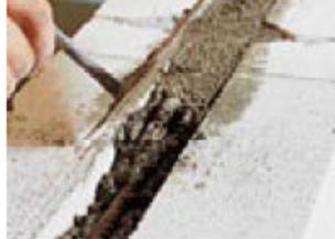
■ Deposite un lecho de mortero fuertemente dosificado en el fondo de la garganta y coloque un redondo HA, de 8 a 10 mm de diámetro.
