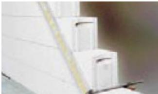
■ Recorte simplemente con un serrucho o una motosierra YTONG las partes sobresalientes de los bloques, apoyándose en las guías.
